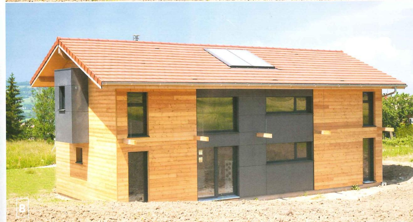
**7** En toiture, 4 m<sup>2</sup> de panneaux solaires thermiques sont orientés plein sud afin de combler 60% des besoins en ECS.
